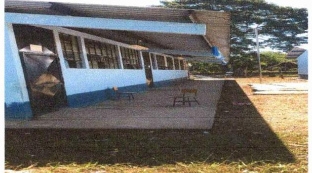
Foto 2: Aulas con necesidad de colocar canales de agua.
